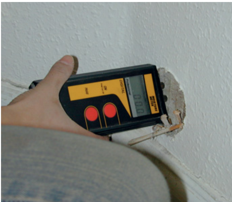
Måling af fugt i materiale.
